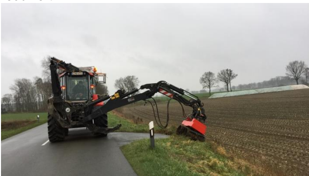
Abbildung 10 Verdichten der gepflügten Strecke
